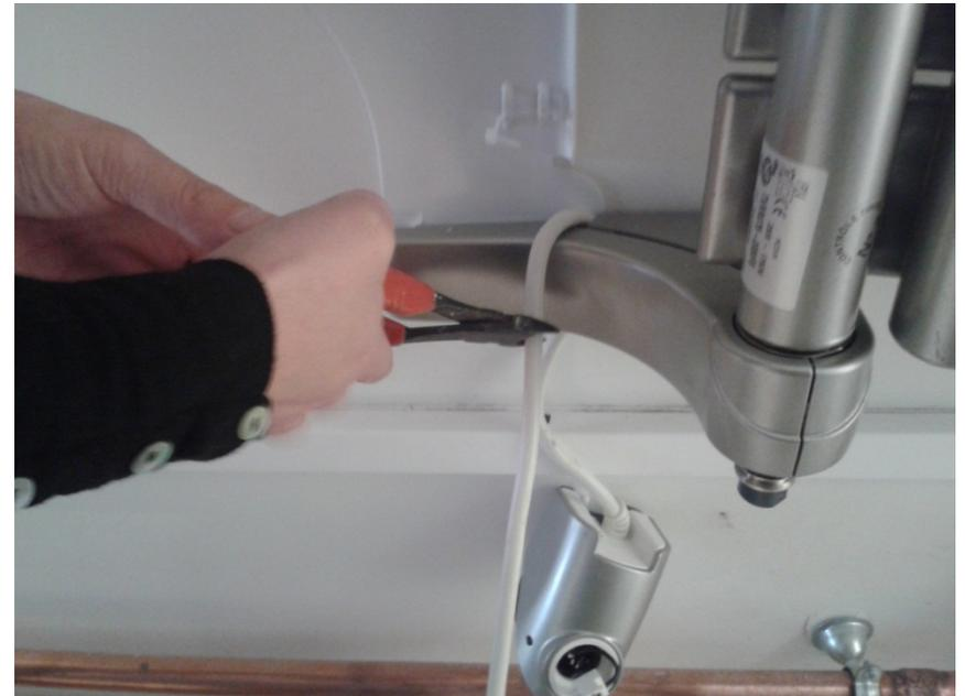
**Déposer le soufflant et couper le câble du récepteur lorsqu'il
