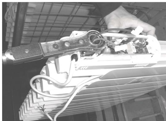
Mettre le boîtier en place ainsi que l'écrou, puis serrer.
